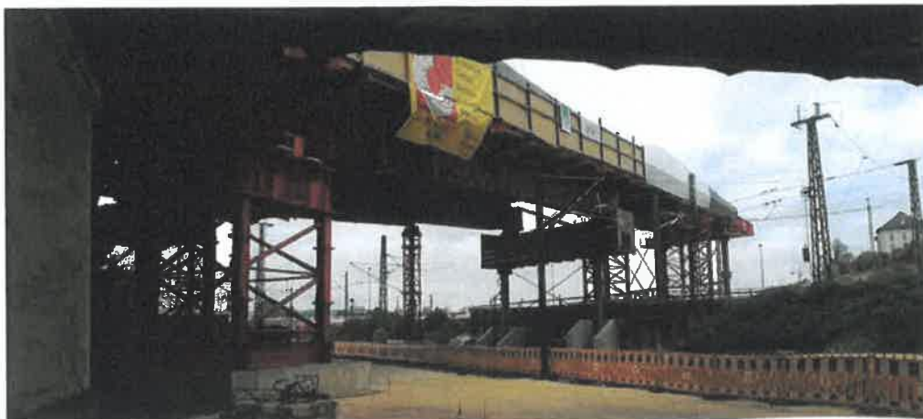
15 Montageplattform nach Errichtung © SEH Engineering GmbH
