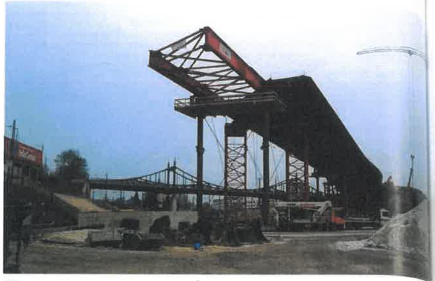
21 Stützenkonstruktion mit Kopfverlängerung und Überbau mit Vorbauschnabel © SEH Engineering GmbH
