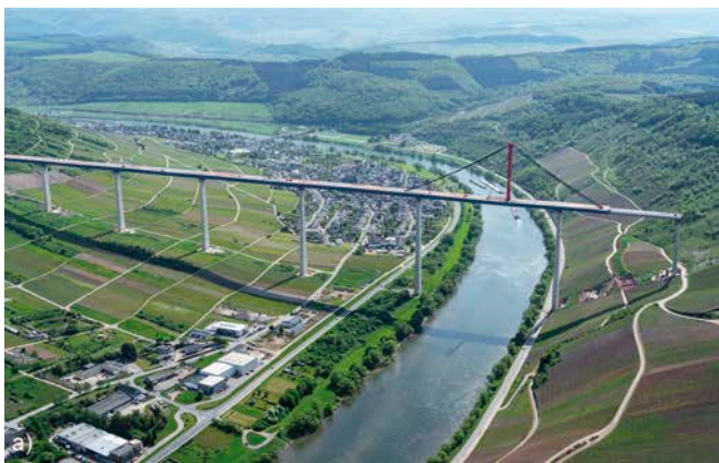
Bild 17 Verschubzustände a) kurz vor und b) nach der Ankunft des Bauwerks auf Eifelseite Sliding states a) shortly before and b) after arrival of the bridge on the Eifel side
