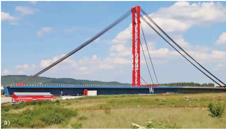
Bild 6 Pylonsystem, bestehend aus a) Hauptpylon (stehend) und b) Hilfspylon (liegend) Pylon system consisting of a) main pylon (vertical) and b) auxiliary pylon (horizontal)
