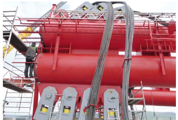
Bild 8 Pylonkopf Pylon head
